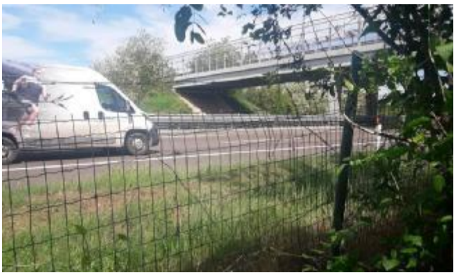
La rete di protezione è stata riparata dopo la segnalazione dei vigili
